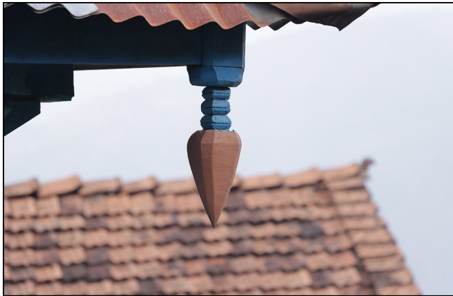
वडा नं. २ रतन्छास्थित घरको छानोमा काठको बुटा ।
